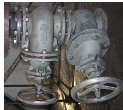
Časť rozvodového zariadenia pred čistením a po čistení technológiou CRYOCLEAN®
